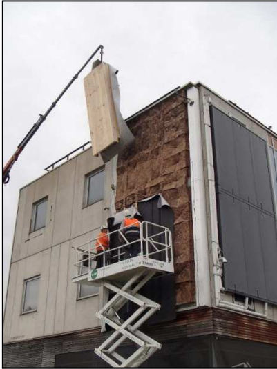
Figura 8. Montaje panel instalaciones en KUBIK
