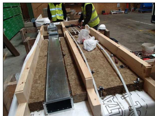
Figura 7. Fabricación de panel de instalaciones en EGOIN
